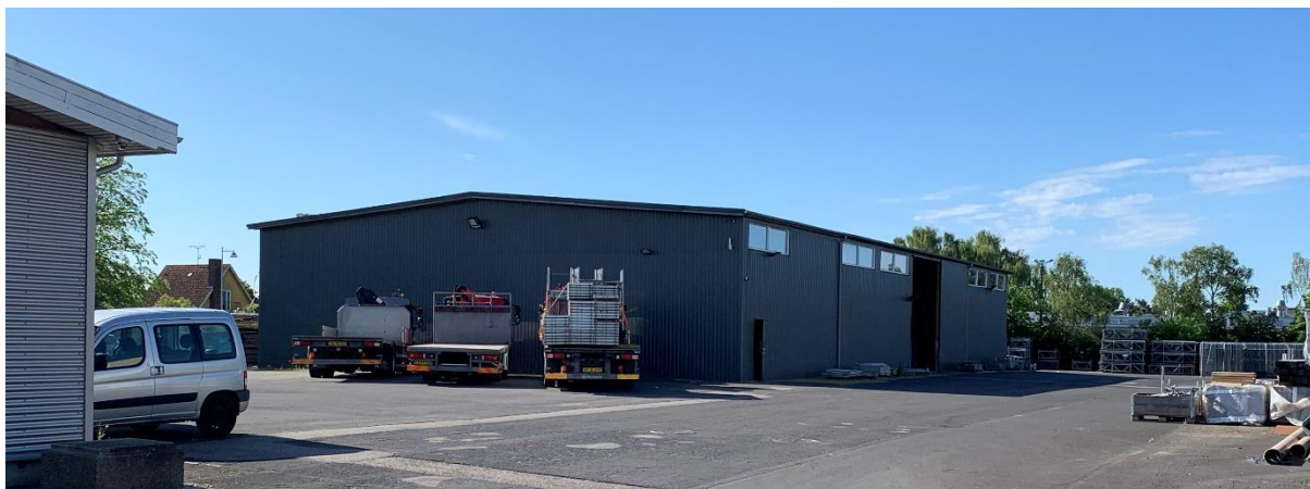
Figur 3.6: Eksisterende lagerbygning, opført i 2007.
