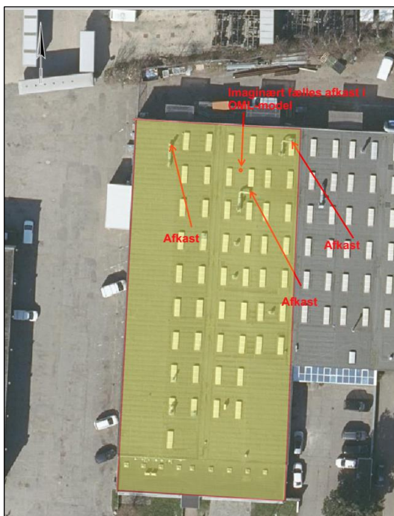
Figur 6.1: Afkast hos JS Ventilation.
