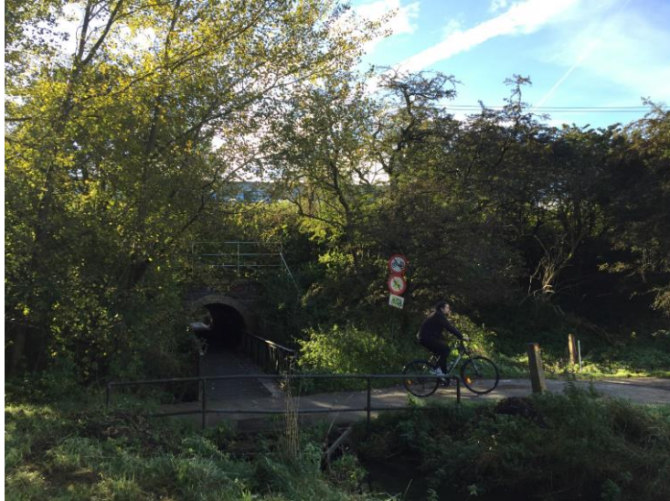
Hyldagerparken i den indre grønne kile – jernbanen gennemskærer kilen. Tunnelen i Hyldagerparken ligger på grænsen mellem by og den grønne kile.
