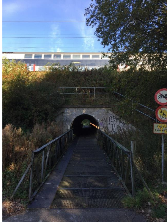
Kongsholmparken i den indre grønne kile – jernbanen gennemskærer kilen. Tunnelen er eneste forbindelse fra Kongsholmparken og Hyldagerparken under jernbanen.
