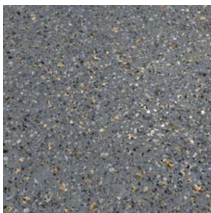
Beton med sten fra området
