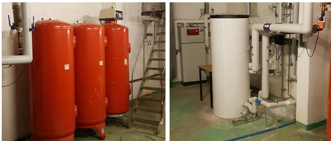
Billede af trykholderanlæg og varmtvandsbeholder på Herstedlund skole.
