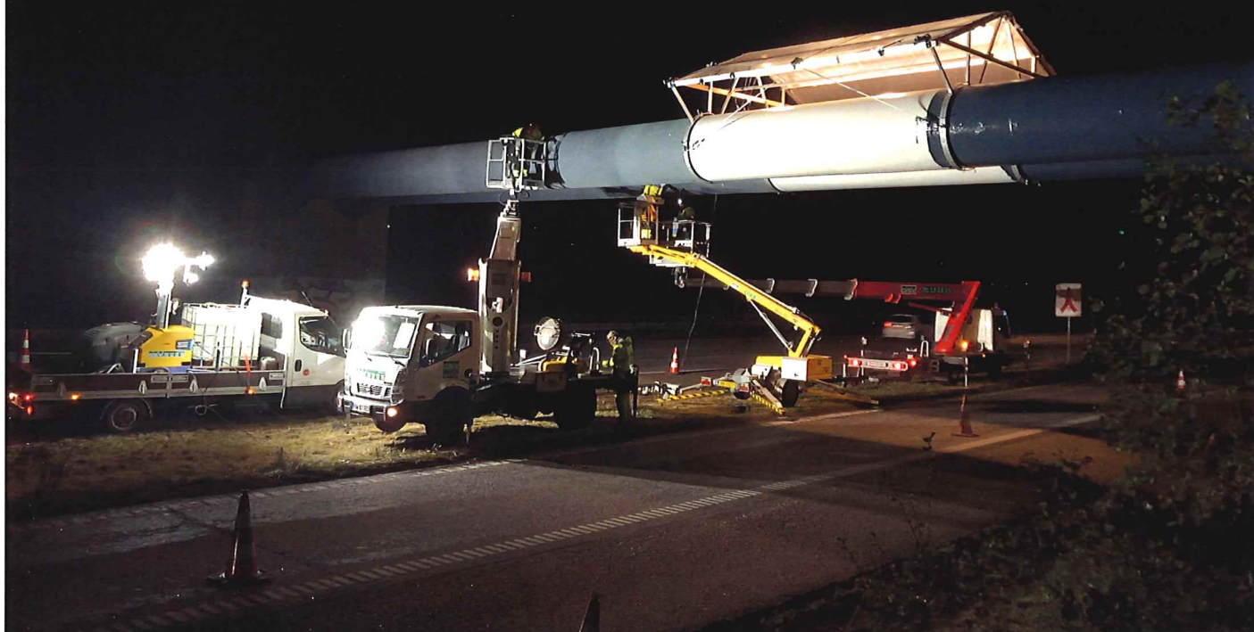
Processen i vedligeholdelsesarbejdet af VEKS' rørbrø ved Avedøre Holme ses fra venstre: Zink-primer, grunder og til sidst maling. Det færdige resultat ses yderst til højre. FOTO: VEKS, Allan Nielsen
