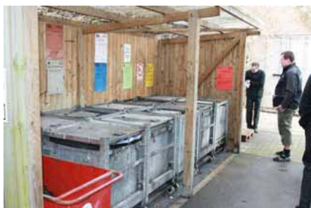
Dobbeltvæggede godkendte affaldscontainere, hvor spildbakken er indbygget.
