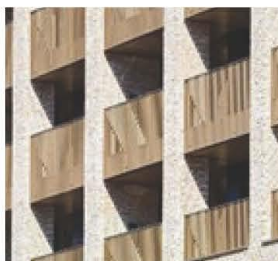
Altaner med lodrette balustre i lysbrunt stål Kilde: Ruskin Square, Allford Hall Monaghan Morris
