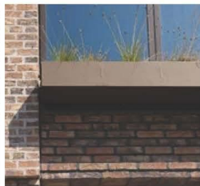
Plantekasser i stål, i farve der matcher husets øvrige malet stålfacader og altaner. F.eks. mørkegrønne, lysbrune eller brunrøde nuancer. Kilde: Amaryllis Hus, Mangor & Nagel
