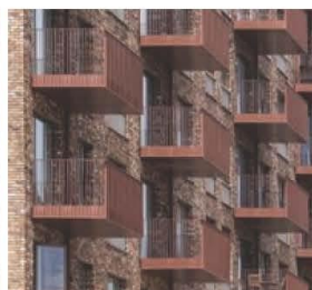
Altaner med lodrette balustre i brunrødt stål Kilde: Amaryllis Hus, Mangor & Nagel
