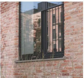
Vinduer, døre i sort eller grå aluminium Kilde: Islands Brygge Parcel B, Henning Larsen
