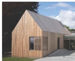
Lys træbeklædning, hvor træets struktur og naturlige gyldenbrune farve er synlig. Kilde: RUBOW Arkitekter
