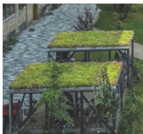
Grønne tage på overdækket cykelparkering Kilde: Fremtidens Gårdhave, Niels Lutzen
