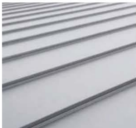
Lysegråt ståltag og facade Kilde: DS Stål
