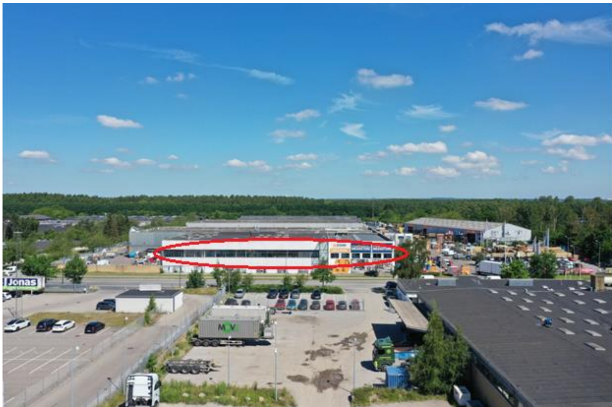
Figur 13: Dronebillede i 20 meters højde, svarende til punkt 7 i figur 4. Jf. lokalplanforslaget planlægges der for op til 6 etager ved denne placering /1/. Vinduesparti er markeret med rød ring.
