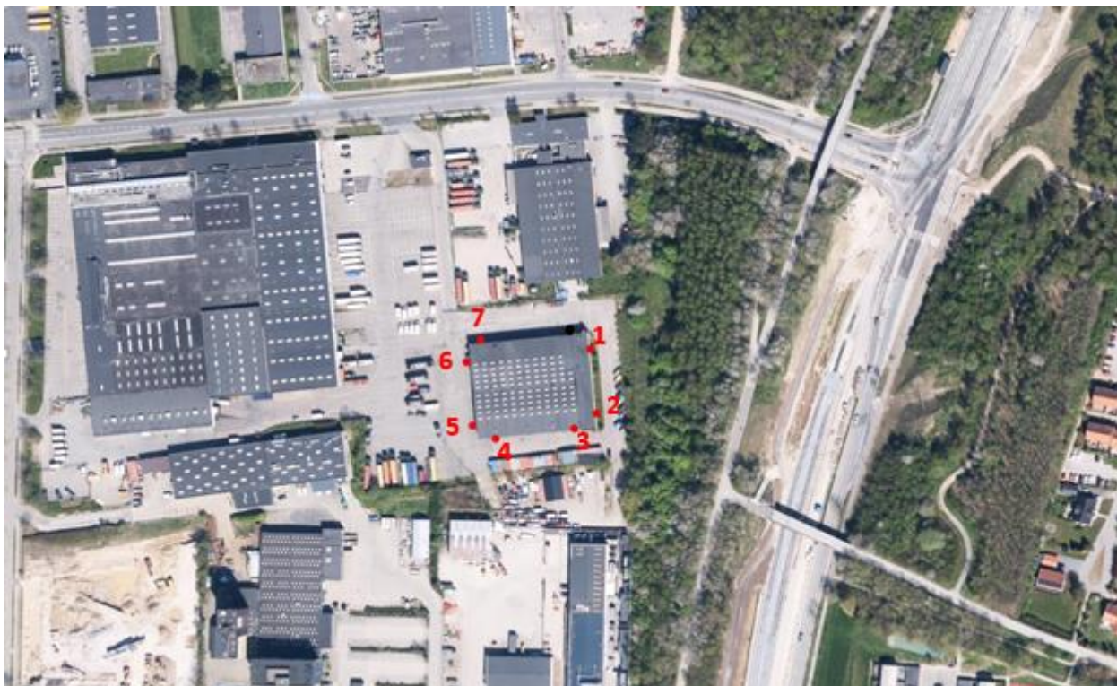
Figur 4: De røde markeringer og tal angiver placeringen for dronebillederne med retning mod de omkringliggende områder. For hver placering er der taget dronebilleder i hhv. 5, 10, 15, 20 og 25 meters højde /1/.
