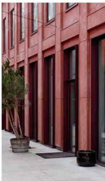
Eksempler på gridstruktur i fibercementplader. Foto: AART.
