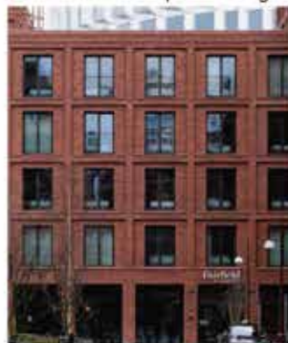
Eksempel på gridstruktur ved brug fremspring i tegl. Foto: AART.
