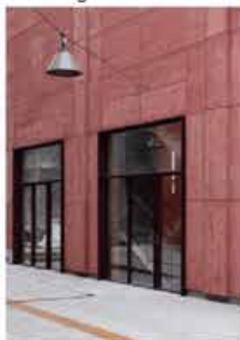
Eksempel på gridstruktur i fibercementplader. Foto: AART.
