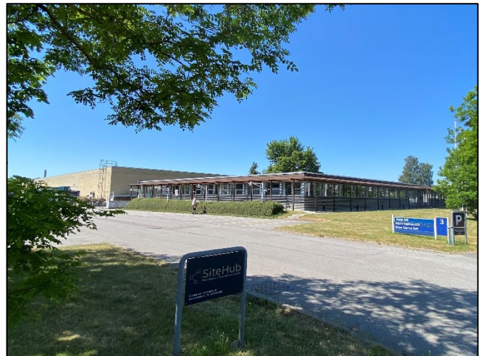
Figur 4: Kontorbygning på matr. 7g med bagvedliggende lagerhal på matr. 8g.
