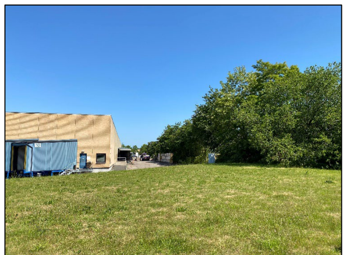
Figur 5: Lagerbygning på matr. 8g med nedgravet rampe og beplantning langs Gamle Landevej.
