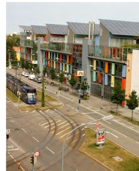
Multifunktionelt hus med butikker i stuen, parkering i midten og boliger på toppen
