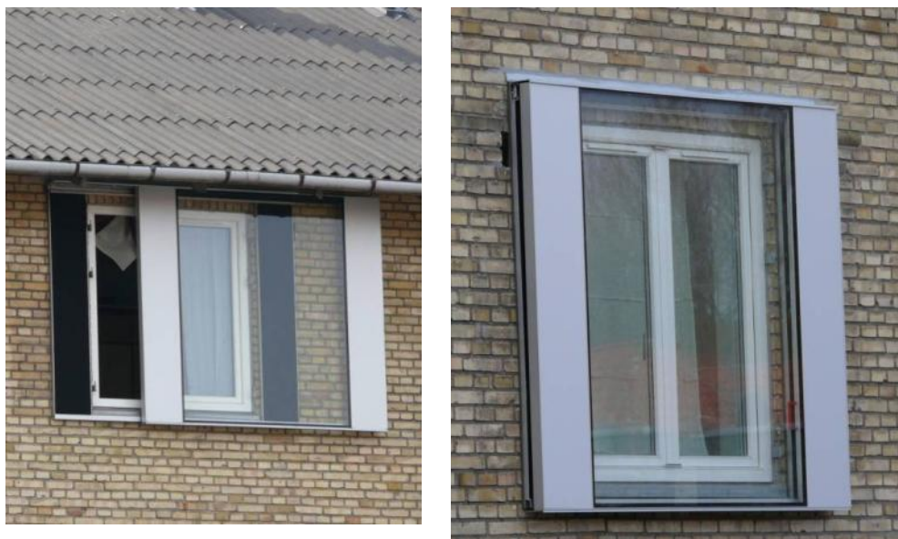
Figur 11. I Folehaven i København har en nogle lejligheder fået monteret en såkaldt lydskodde, der gennem spalter i siderne tillader frisk luft at passere, mens støjen dæmpes. Vinduet kan åbnes på klem bag skodden og skodden kan skyde til side, så vinduet kan åbnes helt.
