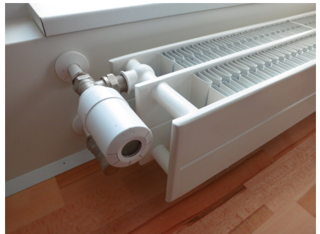
Både energirenovering og større varmeflader er i spil, når lavtemperaturfjernvarme forenes med højkomfort i byens mange bygninger. Her 3-lags radiator i 'Syd' med avanceret centralstyring af temperaturen.
