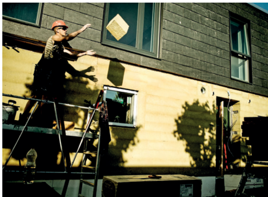
Energirenovering er et af midlerne til reduktion af CO 2 -udledningen i Albertslund. Foto: Janus Enemark Nissen
