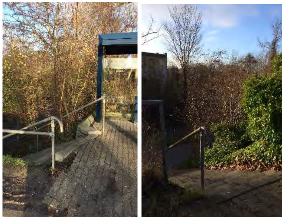
Tranehusene – begge retninger – mangler lys
