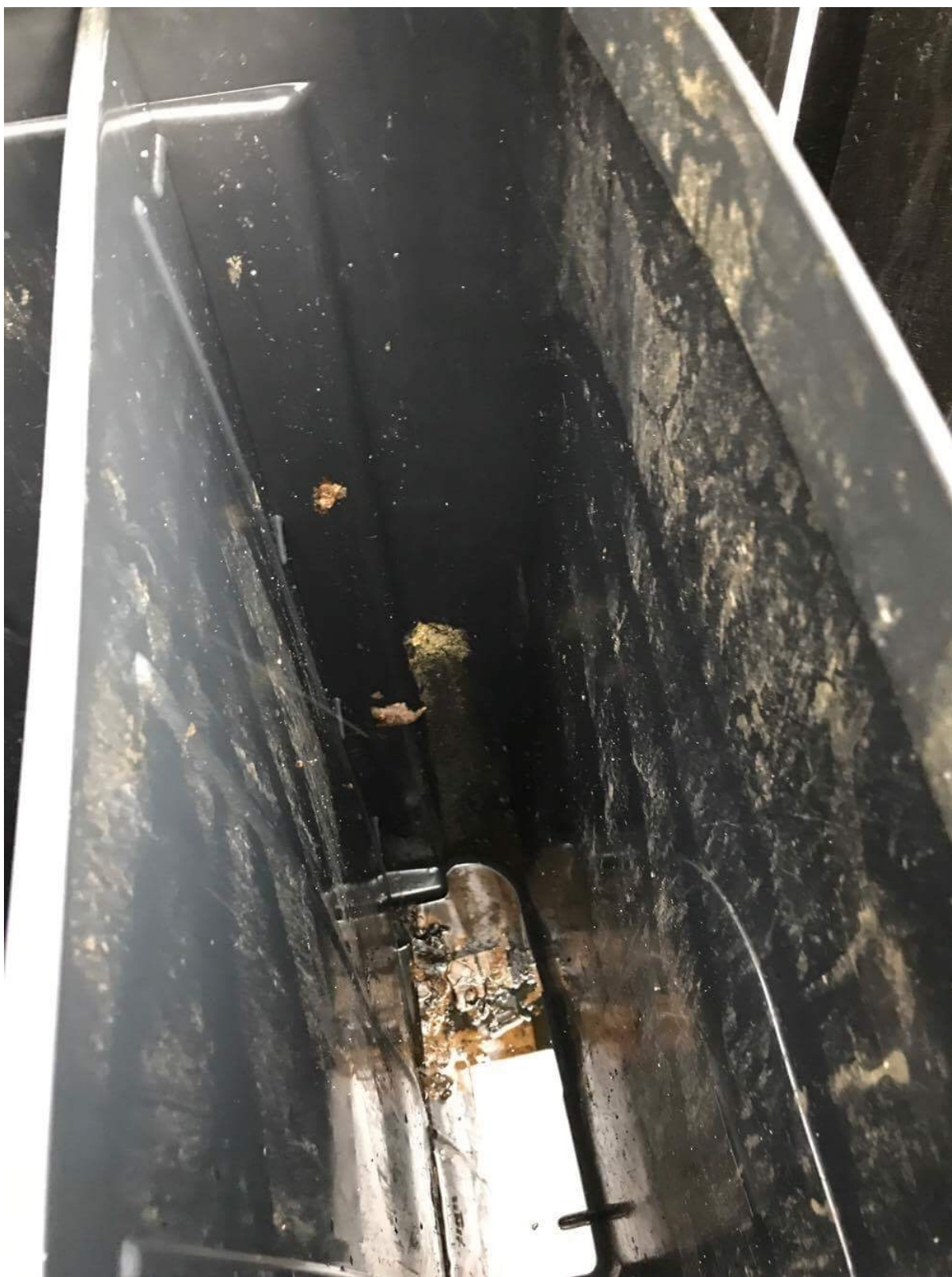
Ikke alle containere var lige rene efter vask – hvilket medførte en del klager – og opfølgende vask.
