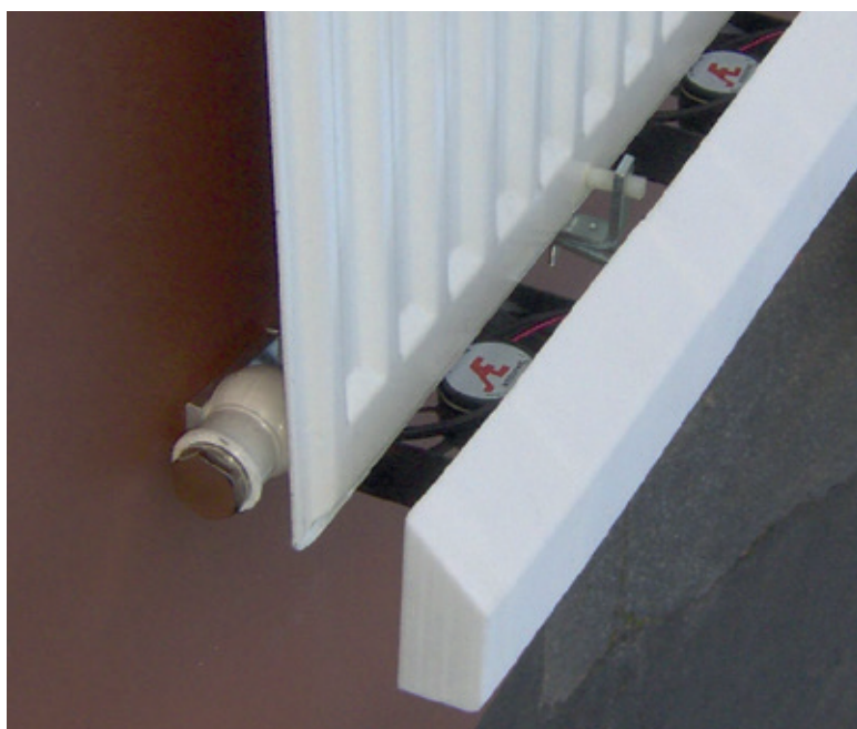
Retrofit blæser kan eftermonteres på alle typer radiatorer. Herved kan selv den tyndeste 60'er-radiator køre med lavtemperatur.
