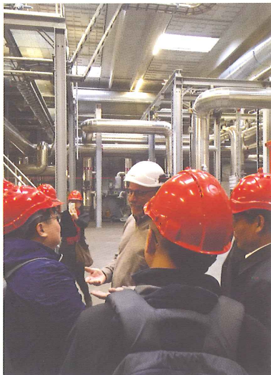
Steen Grummesgaard, KKV viste rundt på kraftvarmeværket og i VEKS' pumpe/vekslerstation i Køge
