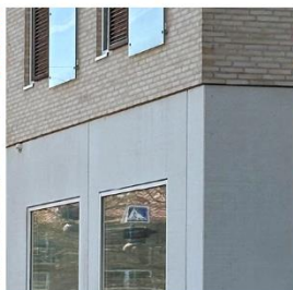
Betonbase og tegl
