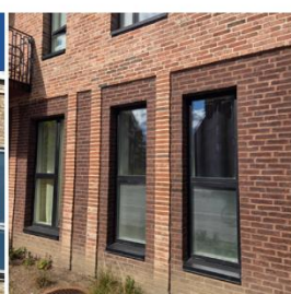
Markering af vinduer med reces og mørkere tegl end basisfladen
