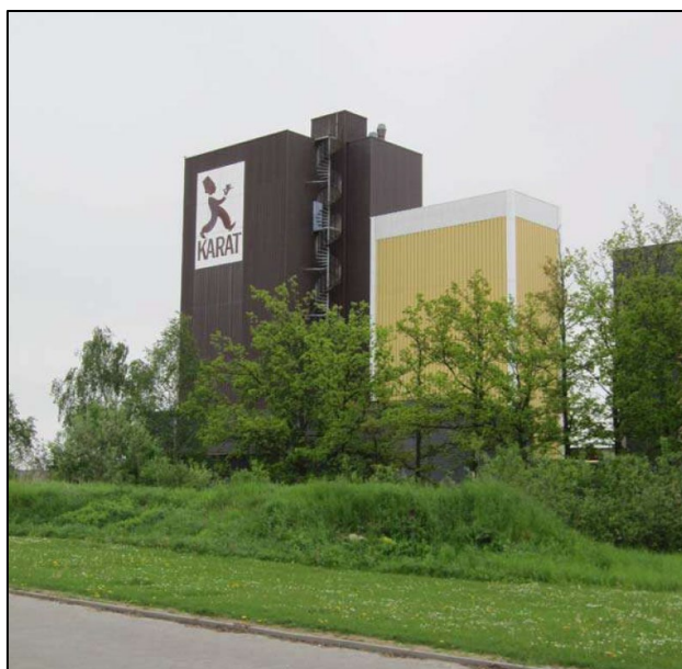
Figur 6: Kaffesiloen er en del af et større kompleks, hvor især de to gulmalede 6 etagers bygninger udgør en væsentlig del af den samlede arkitektoniske komposition.
