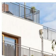
3. Værn af lodrette balastre i stål.
