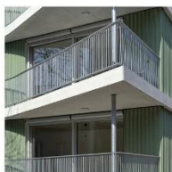
4. Altanværn af lodrette balastre i stål
