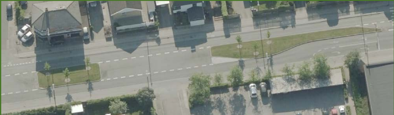
Figur 21: Rødovrevej, omdannet i 2008-2009. Brede, grønne midterrabatter etableret og vejbaner indsnævret for at give plads. Omlægnin- gerne indbyder til lavere hastighed (og derved mindre støj) og sænker vejens barriereffekt. I øvrigt fremstår det også pænt og grønt.
