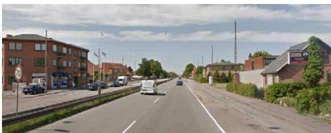
Strækning 2: Bebyggelse - boliger og virksomheder - giver strækning 2 en urban karakter. Fraværet af træer i vejkanterne giver et uoverskueligt vejrum. Bebyggelsen bidrager dog til at danne et overskueligt vejrum. På strækningen findes pæne kulturhistoriske bygninger i vejsiden, samt boliger og virksomheder (særligt i Værkstedsområdet). Også på denne strækning er midterrabatten et forstyrrende element.
