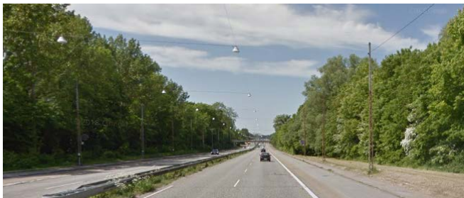
Strækning 1: Forløber gennem Egelundsparken og Hyldagerparken og har et mindre urbant udtryk, præget af store markante træer i vejsiden, der danner et veldefineret rum. Den gamle midterrabat forstyrrer det ellers både grønne og overskuelige vejrum.
