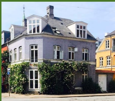
Figur 19: Christianshavn, København. Facade på eksisterende bygning begrønnet. Lignende tiltag på randbebyggelse langs Roskildevej kan bidrage til at skabe et grønt vejrum.
