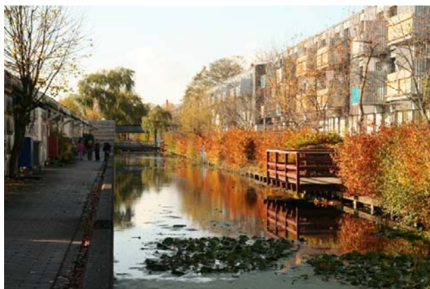
Kanalen – regnvandsbassin i bymiljøet og en del af en blå struktur.
