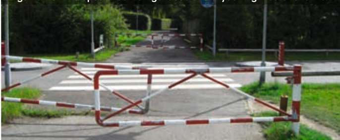
Figur 5 Bomme opsat ved Damgårdstiens krydsning med Skallerne.
