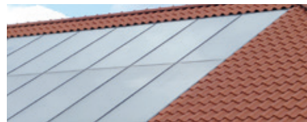
65 m 2 solvarmeanlæg installeret i Køge.
