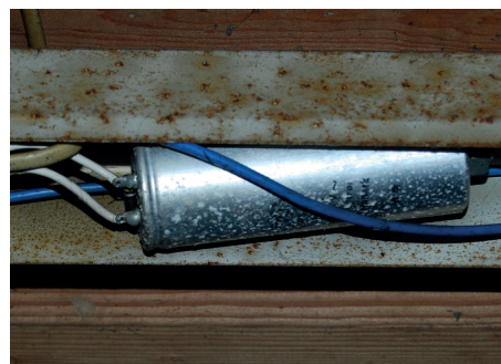
Ældre kondensatorer indeholder ofte PCB.
