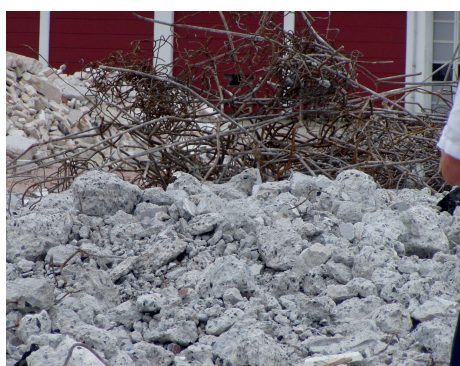
Nedknuet beton og armeringsjern. Betonen genanvendes og jernet smeltes om.
