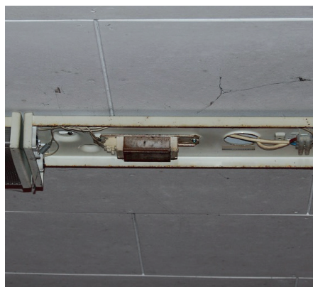
Ældre armaturer til lysstofrør indeholder ofte PCB.
