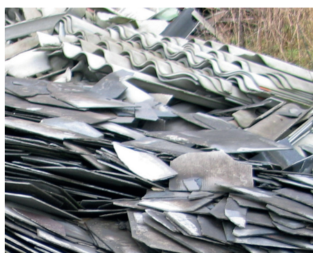
Affald af eternitplader oplagret i strid med reglerne. Eternitplader skal tages hele ned og må ikke beskadiges, da de afgiver farlige asbestfibre. Beskadigede plader skal være forsvarligt emballerede i støvtæt emballage.
