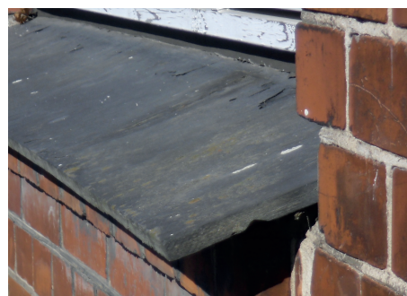
Sålbænk – kan indeholde asbest. Hvis der er usikkerhed om indholdet af asbest, skal materialerne håndteres, som om de indeholder asbest. Ved større mængder skal der foretages analyse.
