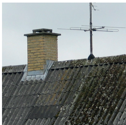
Ældre eternittage indeholder som oftest asbest.
