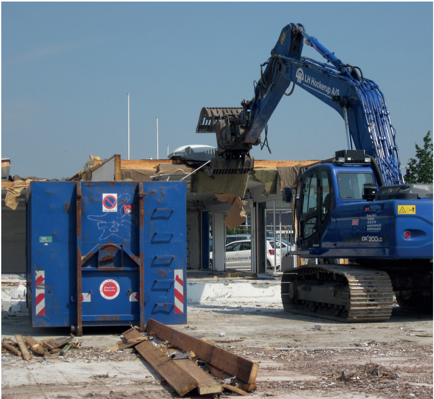
Nedrivning hvor affaldet sorteres umiddelbart.
