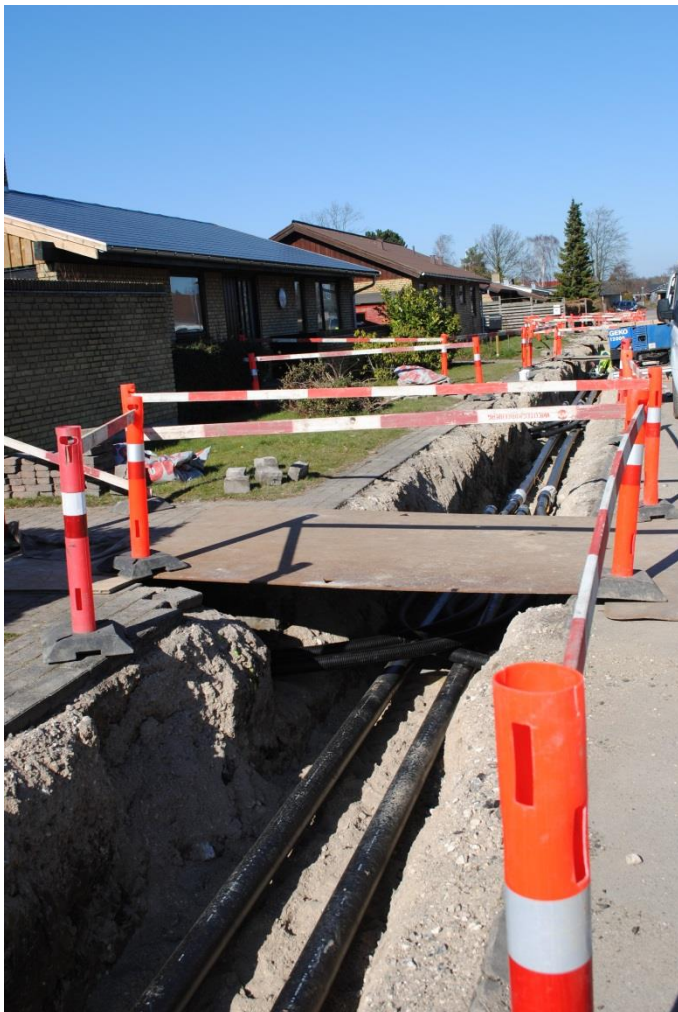
Renovering af fjernvarmerør på Kongsager
