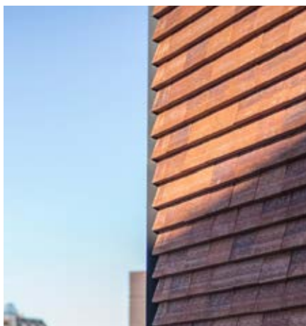
Eksempel på hjørne afsluttet skråtskåret med metalprofil.
