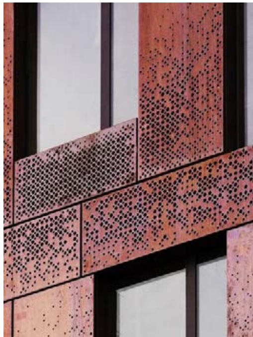
Eksempel på plademateriale med perforeringer, der giver karakter og dybde til overfladen.
