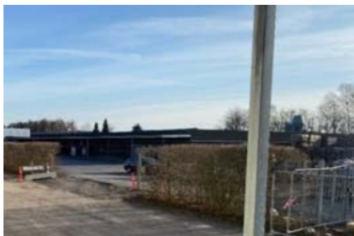
Figur 97: Foto, som viser eksisterende bebyggelse på Smedeland 8B.
