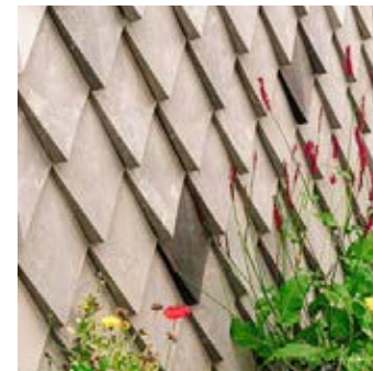
Plastik shingles / Polycarbonat Plastik shingles giver dybde og variation i facaden
