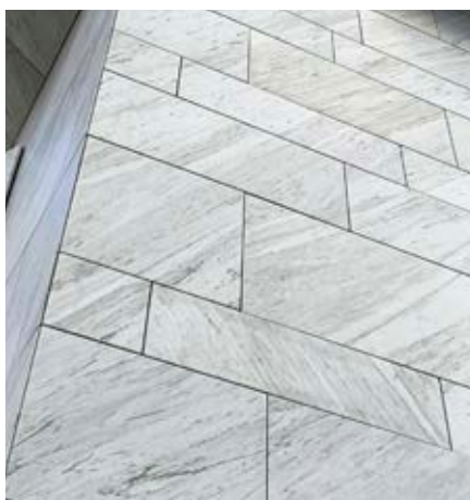
Eksempel på ophængt natursten udført i skiftende længder.
