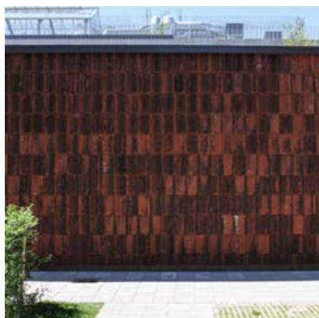
Eksempel på ophængte tegl i lige forbandt. Her udført med genbrugte lervingetegl der tilsiger, at teglene skal hænge over hinanden i lige linie.
