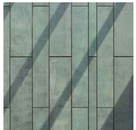
Eksempel på metalplade med lodret opdeling. Pladerne er monteret i varierende længder for at minimere den visuelle vandrette opdeling og i stedet fremhæve den lodrette struktur.
