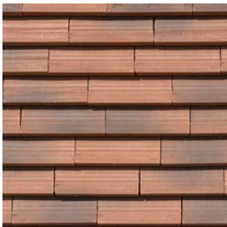
Eksempel på skærmtegl opført med forskudt forbandt.
