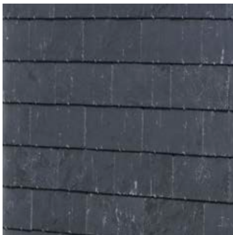
Eksempel på delvist skjult ophængningssystem. Naturstenen er her ophængt med krog i bunden af stenen.
