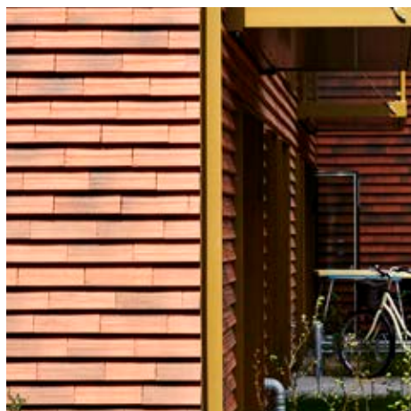
Eksempel på hjørne afsluttet med et åbent hjørne i metalprofil.
