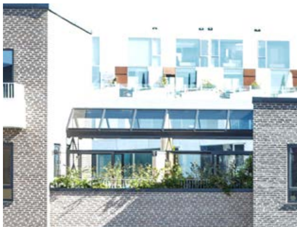
Eksempel på tagterrasse værn udført i kombination med plantebed der giver en begrønnet udtryk..
