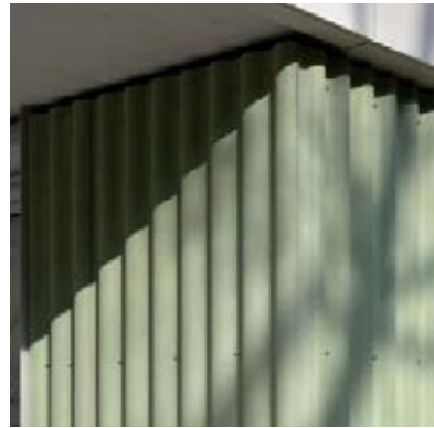
Eksempel på fibercementplade udført med reliefvirkning - her udført som sinusplade der er med til at give en flot detaljering og skyggevirkning på facaden.
