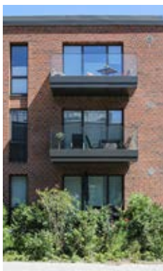
Eksempel på altanværn udført som indspændt glas.
