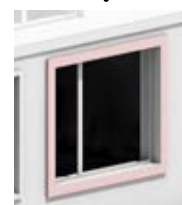
Vindue med detaljering
