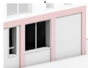
Detaljerings ved gennemgående recesmotiv der giver reliefvirkning jf. § 6
