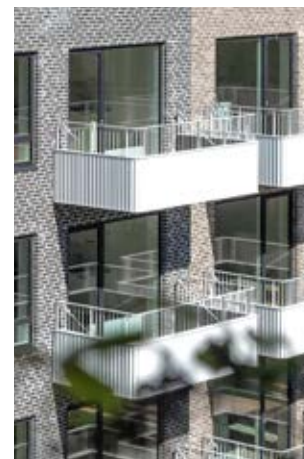
Eksempel på altanværn udført i kombination af lodrette balustre og lukkede plademateriale. Den lukkede del er her udført i malet sinusplade.
