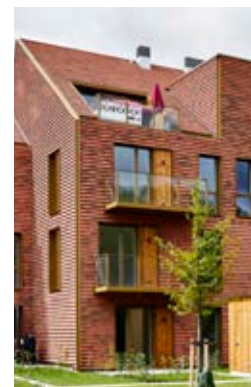
Eksempel på altanværn udført i glas med punktvise afbrydelse med lodrette balustre hvorpå glasset er monteret.
