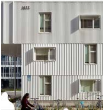
Eksempel på plademateriale udført i aluminium med lodret reliefvirkning. Reliefvirkningen er her lavet i 3 forskellige bredder, der giver en naturlig overgang i pladernes højder.
