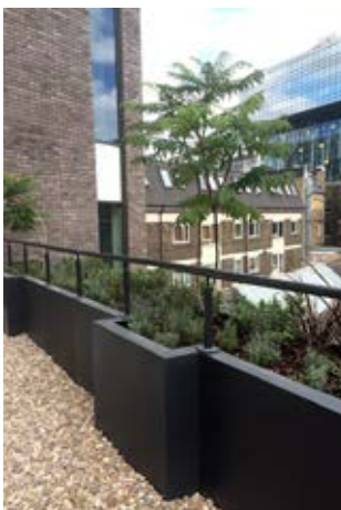
Eksempel på tagterrasse værn udført i kombination med plantebed der giver en begrønning..
