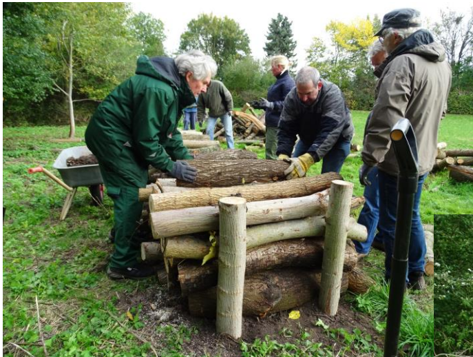
Brændemuren anlægges i Egelundparken
