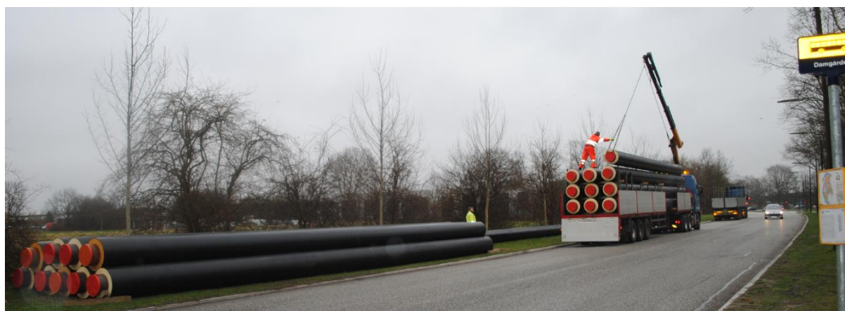
Overgang til lavtemperaturfjernvarme sker samtidig med nødvendig udskiftning af ledningsnettet.
