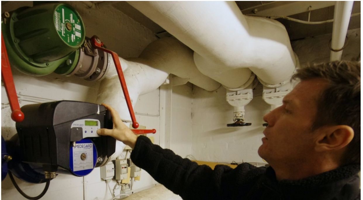
En medarbejder fra Varmeværket hjælper 'Værkstedsgården' med pumpeotimering
