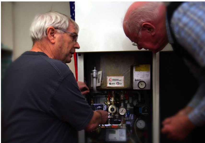
Medarbejder fra Albertslund Varmeværk instruerer en villaejer i brug af dennes tilslutningsanlæg, også kaldet en fjernvarmeunit.
