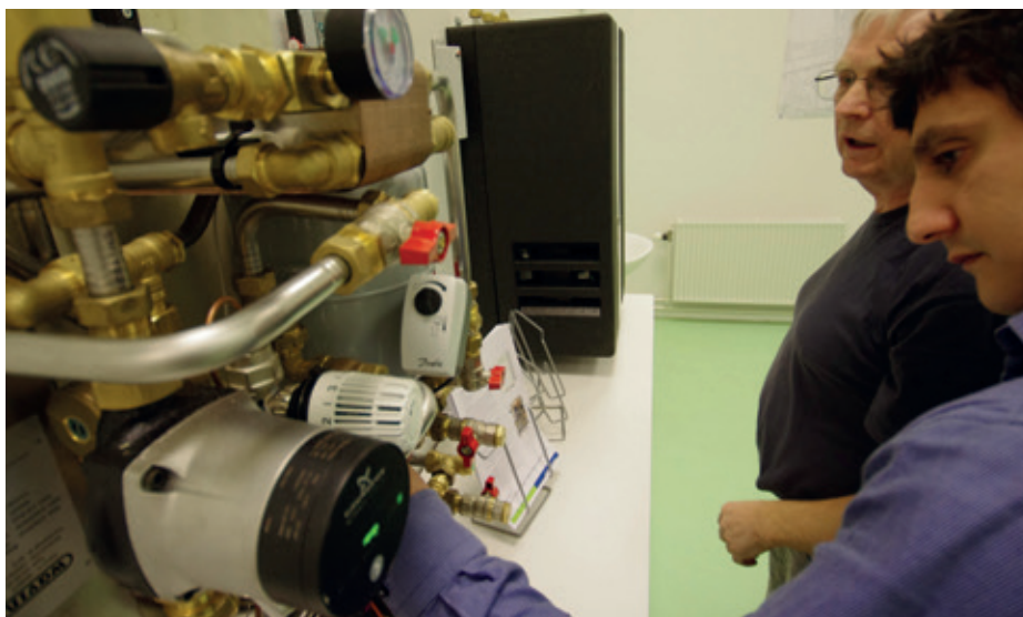
Kurt og Wisam fra Albertslund Forsyning med øjnene på - og fingrene i et tilslutningsanlæg.
