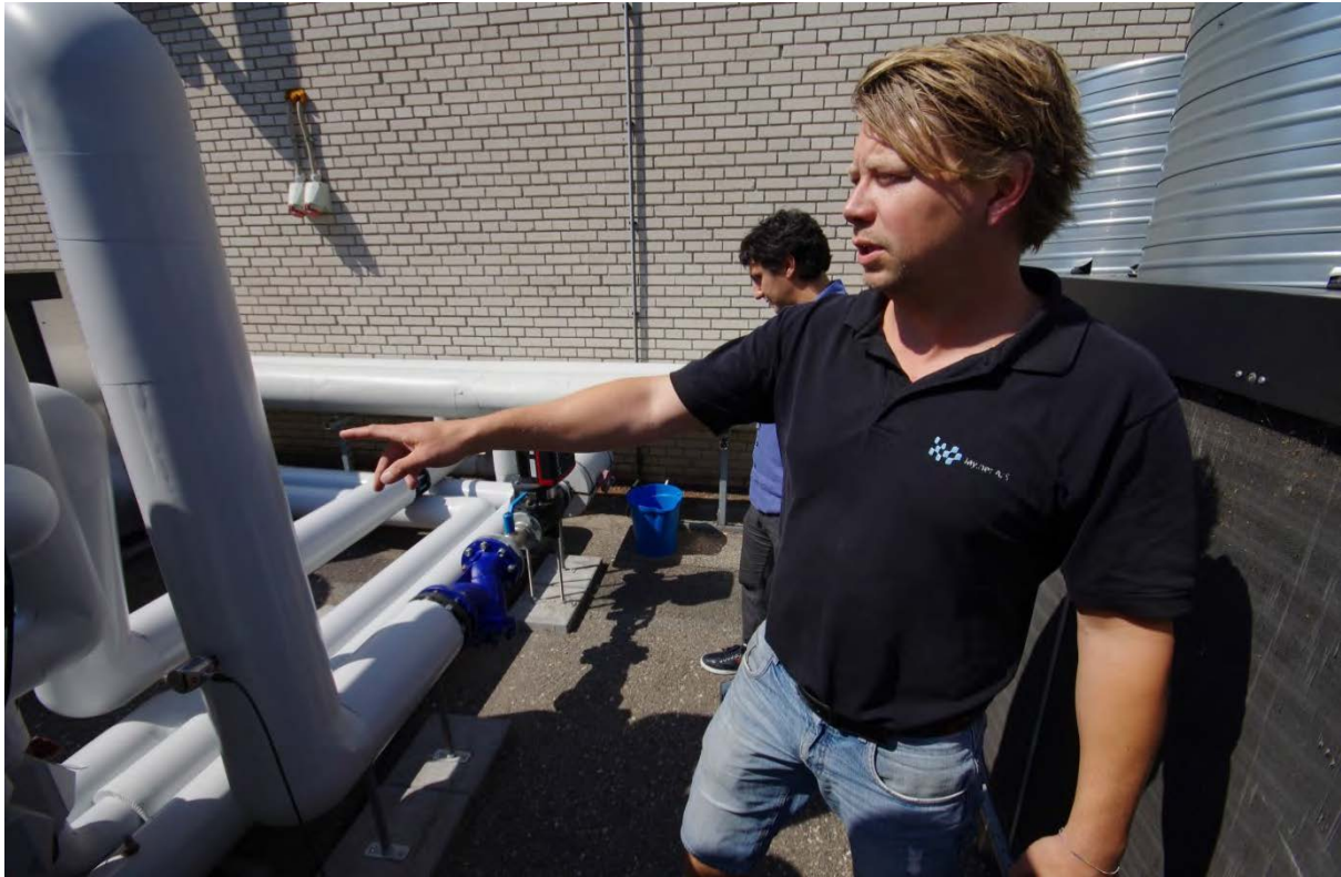
Servervirkersomheden JayNet i Hersted Industripark fik med stort energitilskud etableret sin første varmepumpe til intelligent genbrug af overskudsvarme fra serverrum. Før var overskuddet varm luft over Albertslund Øst, nu bliver energien behændigt konverteret til fjernvarme som et ud af kun to steder i hele Danmark. JayNet fik kommunens 'Grøn Initiativpris' 2015. Foto: Christian Oxenvad
