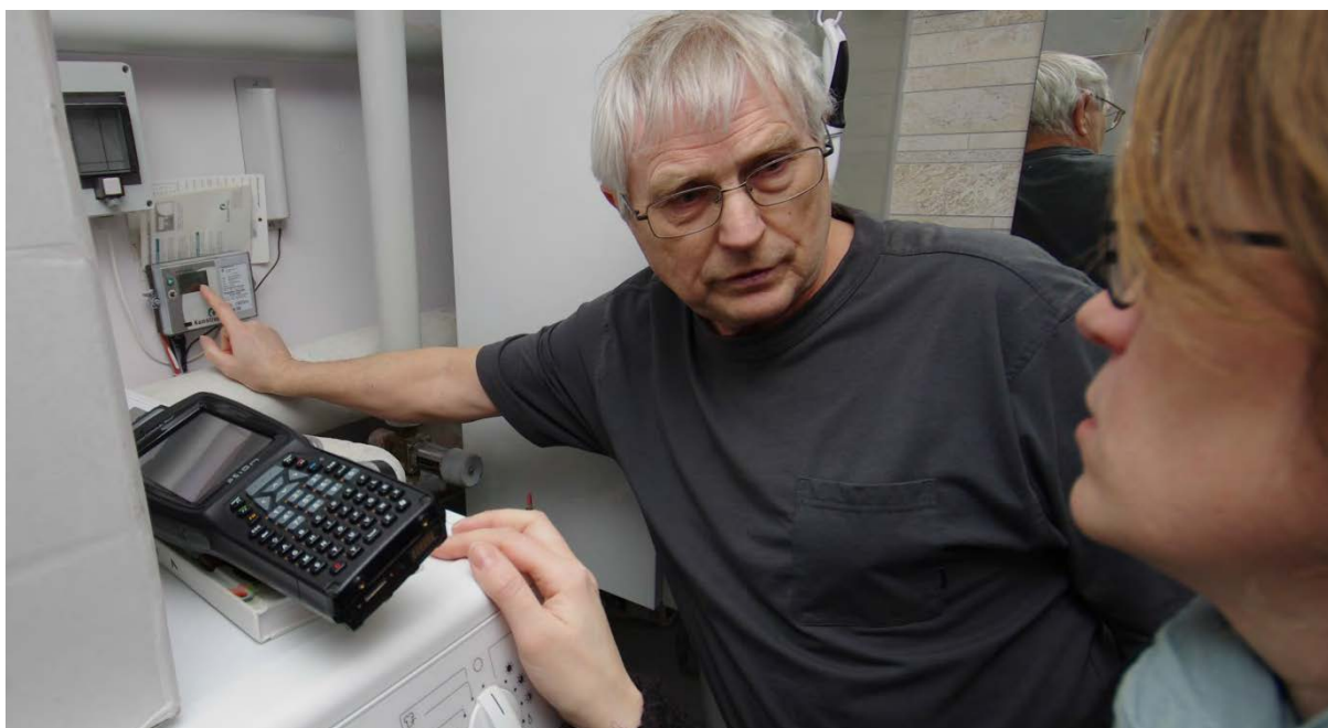
Værkets erfarne VVS'er Kurt Nielsen underviser her en rækkehusejer i varmemåling. Med nye intelligente varmemålere vil det overalt i kommunen på et tidspunkt blive muligt at følge forbrug og afkøling online, time for time, til gavn for både slutbrugere og det 'store' fjernvarmesystem. Foto: Christian Oxenvad
