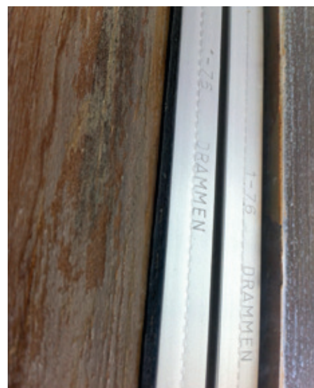
Termorude, hvor prægningen i afstandslisten viser, at ruden er fra 1976. Ruden indeholder muligvis PCB, da der i 1976 anvendtes PCB ved fremstilling af termoruder.
