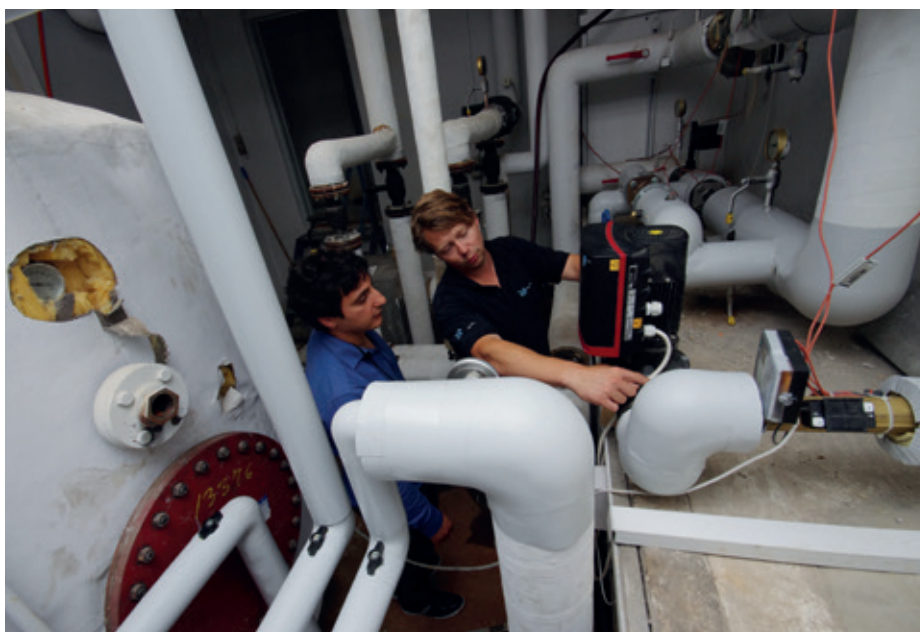
Civilingeniør Wisam El-Khatib (tv) fra Albertslund Forsyning og Martin Axelsen (th) fra Jaynet A/S studerer en ny cirkulationspumpe i virksomhedens 'boilerum' - fordelingscentralen for varmt vand.
