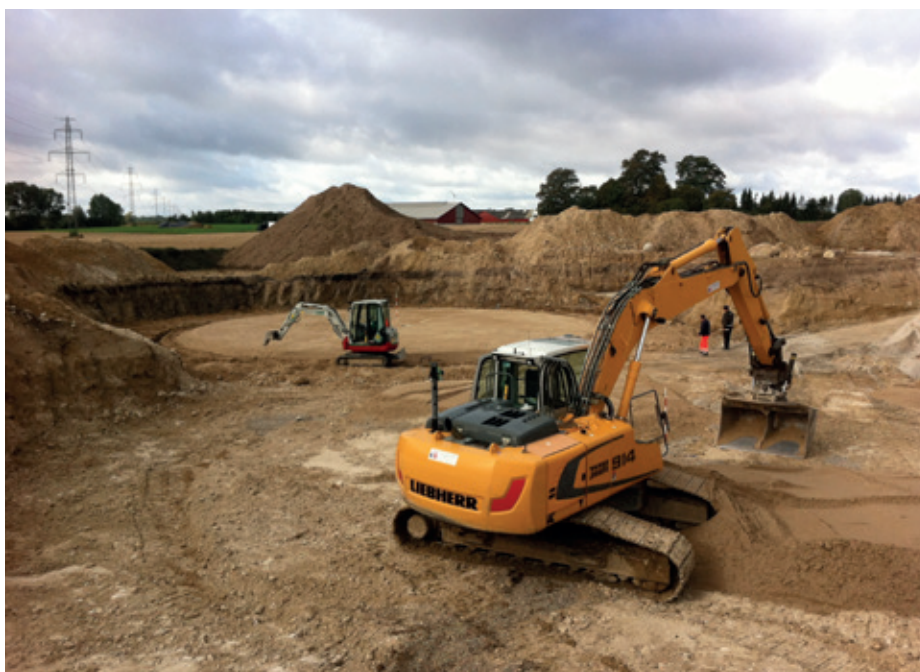
Udgravning til reaktortanke, september 2014.
