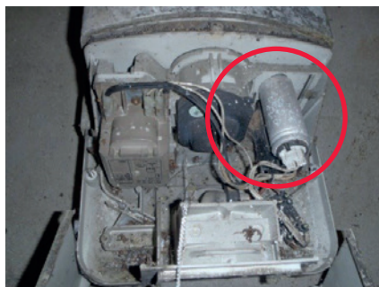
Kondensator i armatur til natriumlampe.
