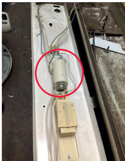
Separat kondensator i lysstofrørarmatur.
